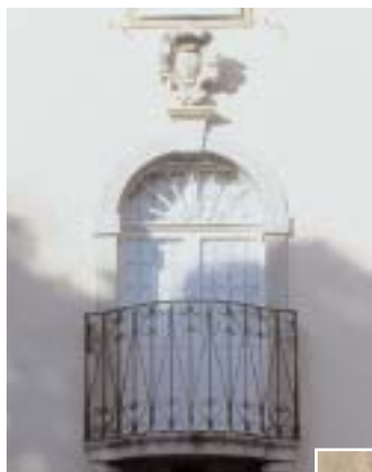
In alto: Villa Masotti, particolare della facciata.
